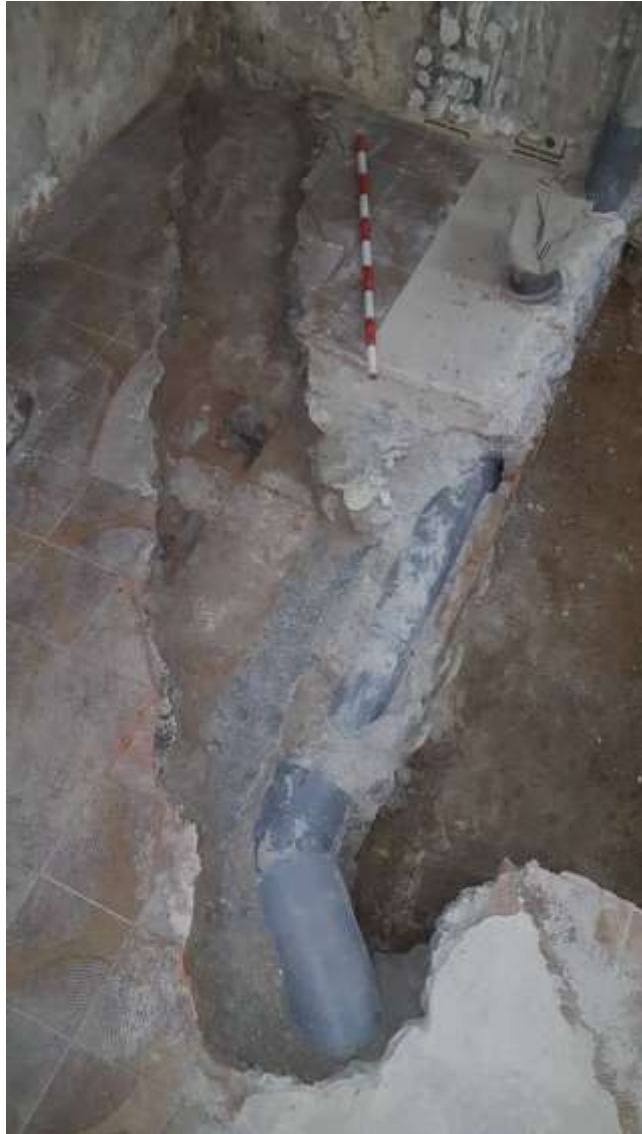
Imatge de la UE 03 identificada a la rasa de serveis
